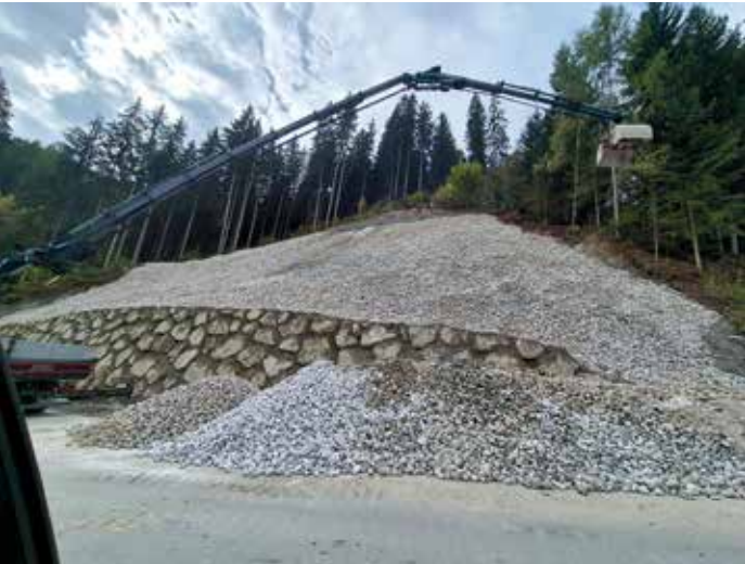
Sanierung der Landesstraße auf die Planai
