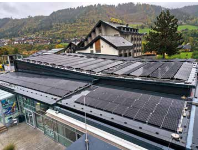
Die PV-Anlage am Dach des Erlebnisbades.
