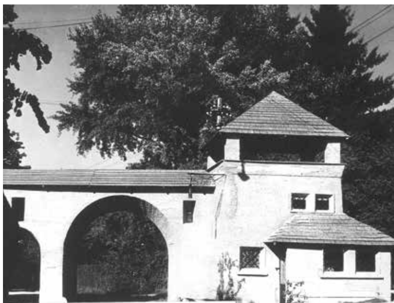
Im Rahmen der Feierlichkeiten zur Wiedererlangung des Stadtrechtes wurde am östlichen Rand des Stadtkerns das ehemalige zweite Stadttor, das „Grazertor“, rekonstruiert.
