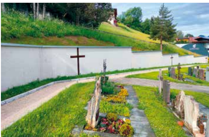
Fertigstellung der Urnenwand am Friedhof
