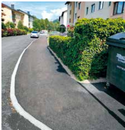
Bild oben & rechts: Sanierung Sportplatzgasse
