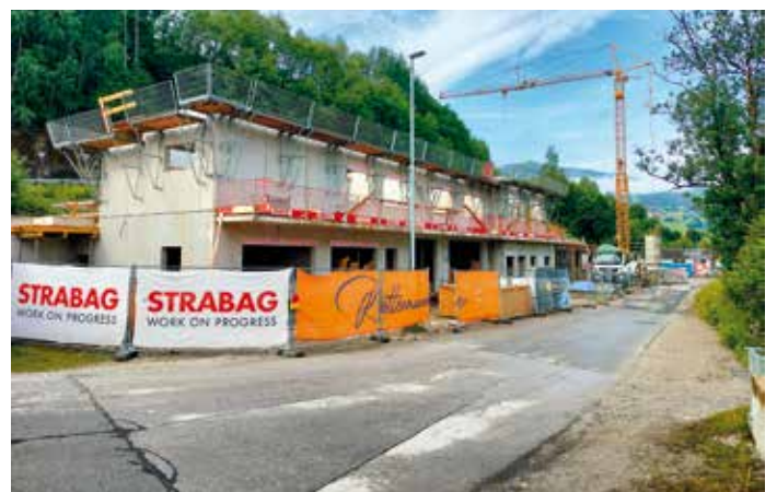
Bau des Einsatzzentrums
