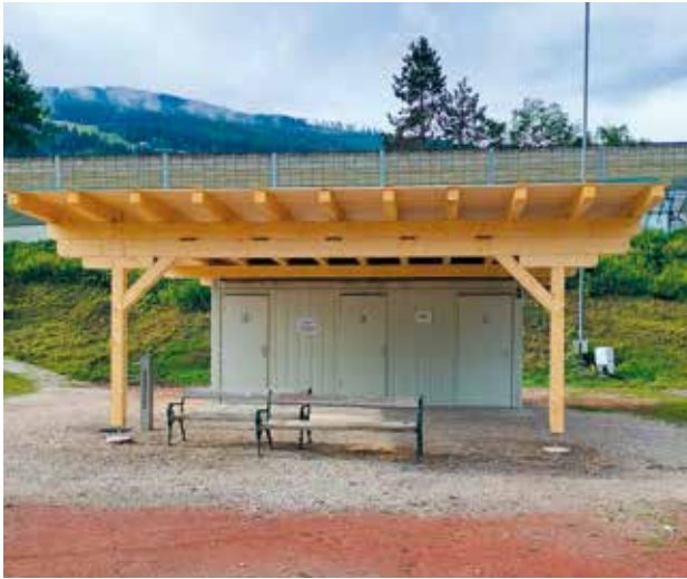
WC-Container und Trinkbrunnern am Ennsperk
