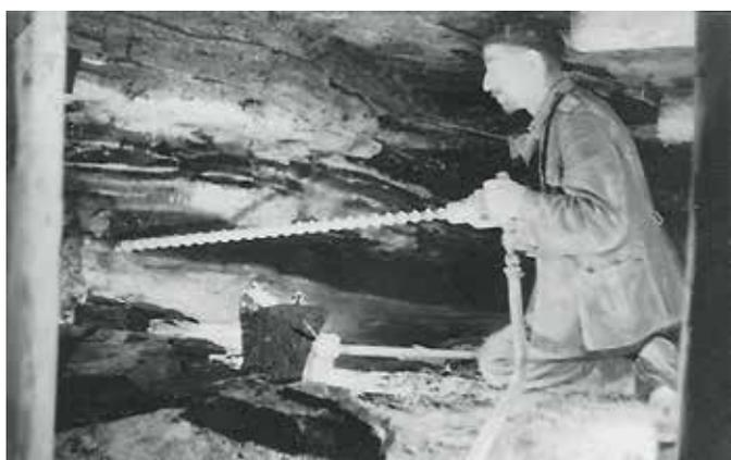
Abb. 7: Der Hauer Gottlieb Engelhardt bei der Herstellung eines Sprengloches mit Hilfe einer pressluftbetriebenen Drehbohrmaschine. Ein Foto aus dem Jahr 1947 (Museum Schladming).
